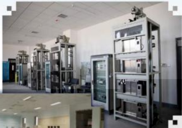
智能电梯安装调试维护训练场所
